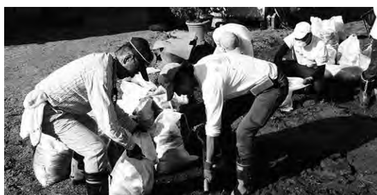
協力し合いながら土のう袋に土を詰めていきます
